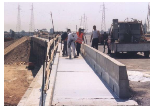
PROTECCION DE PUENTES
