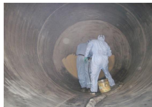
PROTECCION DE TANQUES
